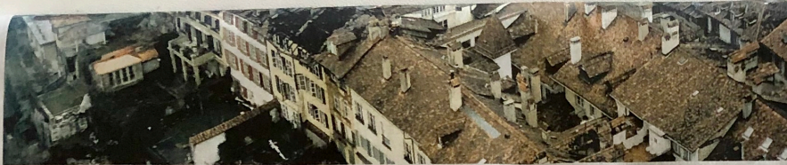
Der Brand von 1997 verursachte Schäden von rund 25 Millionen Franken. Investitionen ab 2000 Franken sollen eine Wiederholung verhindern. Keystone
